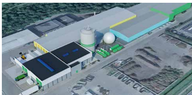
Vernieuwde composteerinstallatie met nieuwe ontvangst- en voorbereidingshal, vergister en biogasinstallatie.
