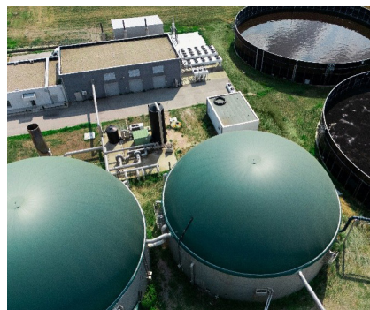
Figuur 17: Overzichtsfoto biogasinstallatie
