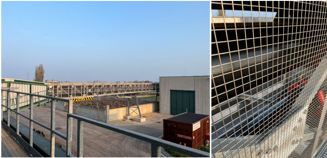
Figuur 10: Oprollende transportbanden transporteren de voedingsmix naar de vergisters met minimale geurhinder voor de buurt.
