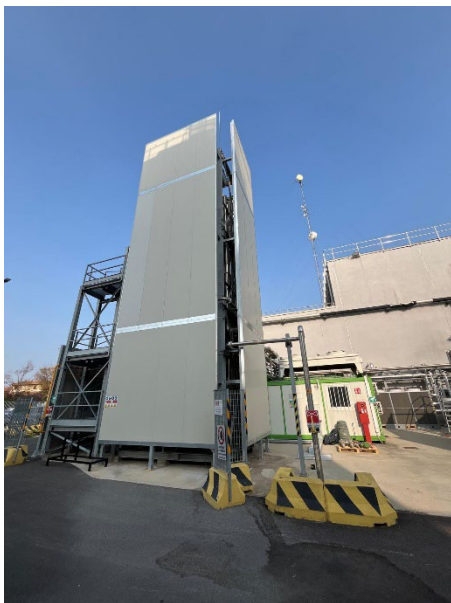
Figuur 8: Biogas opwerking door absorptie over carbonaten.
