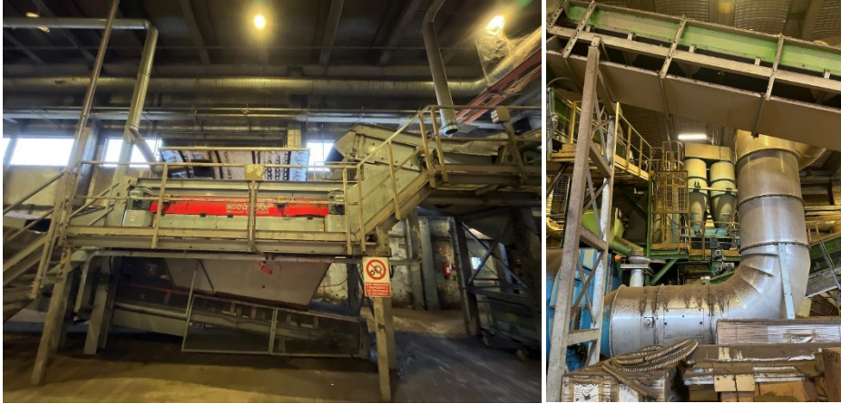
Figuur 6: Affinage van compost via sterrenzeef en densimetrische scheiding.
