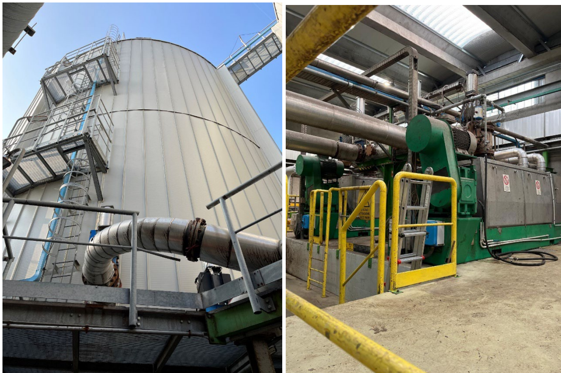
Figuur 2: Vergistingstank en schroefpers.
